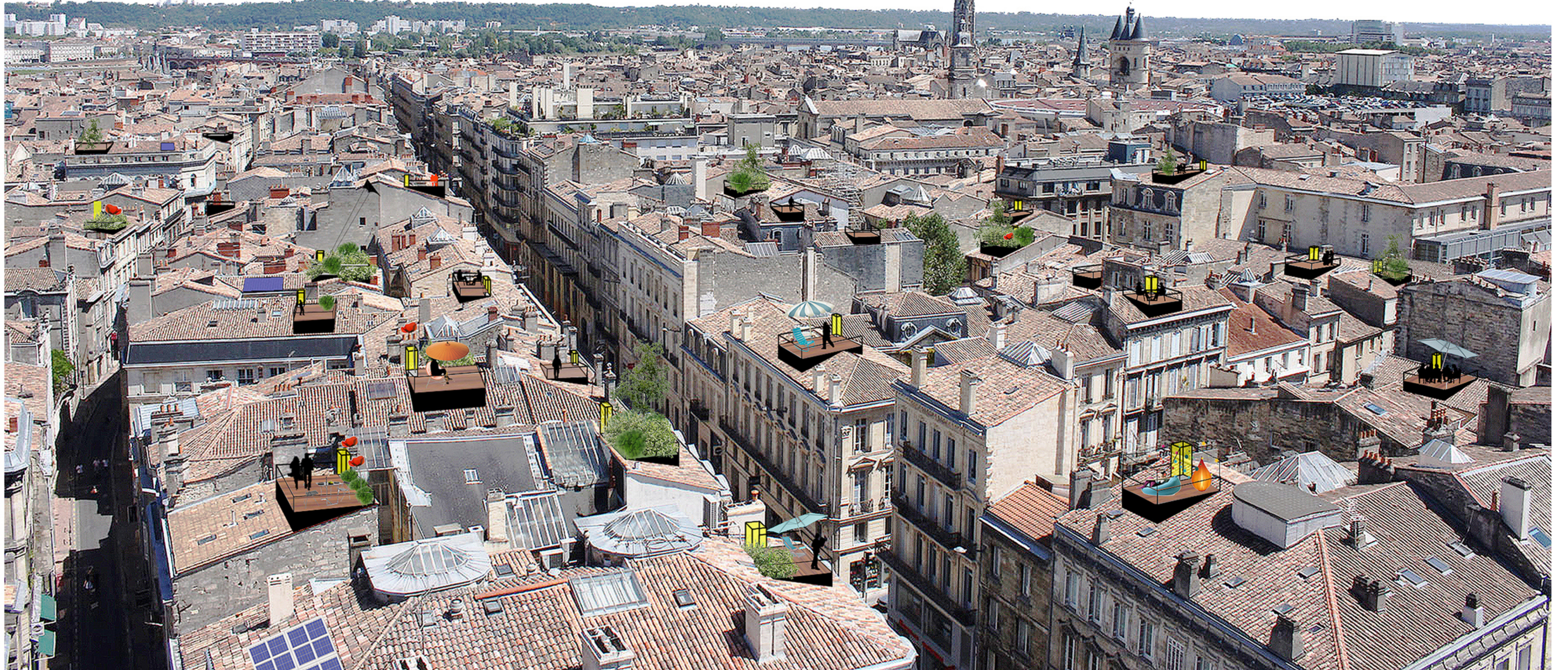
_Vue Perspective_ EasyRoof propose une intervention ponctuelle sur les toits, sans entraver la lecture du skyline typiquement bordelais. C'est une intervention mineure à l'échelle de la ville, une intervention facile à l'échelle individuelle dont les bénéfices sont un gain d'espace, d'habitabilité et de confort en créant des espaces à vivre supplémentaires dans les centres anciens denses.
