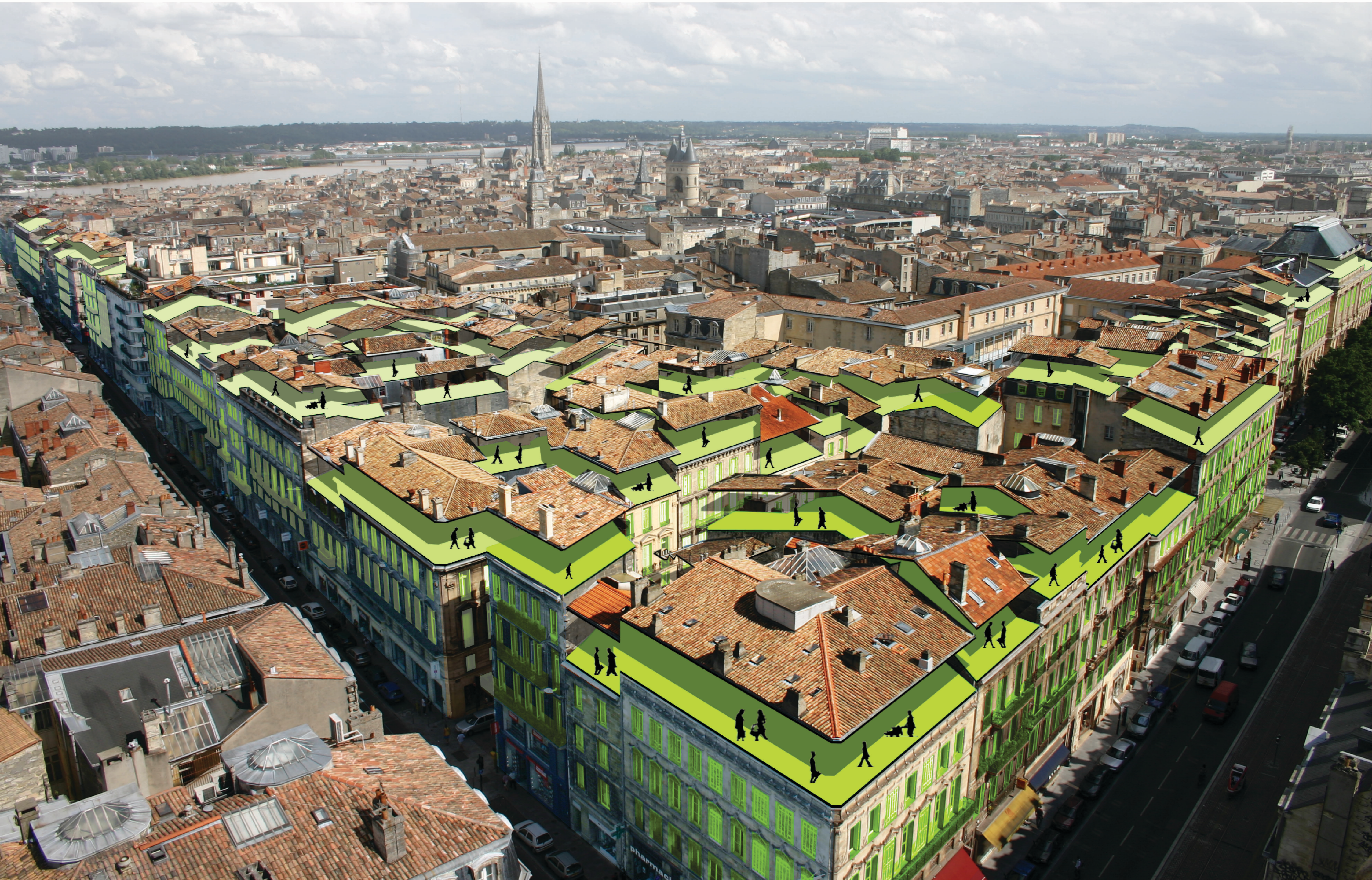
Vue générale des toits depuis la flèche de Pey-Berland
