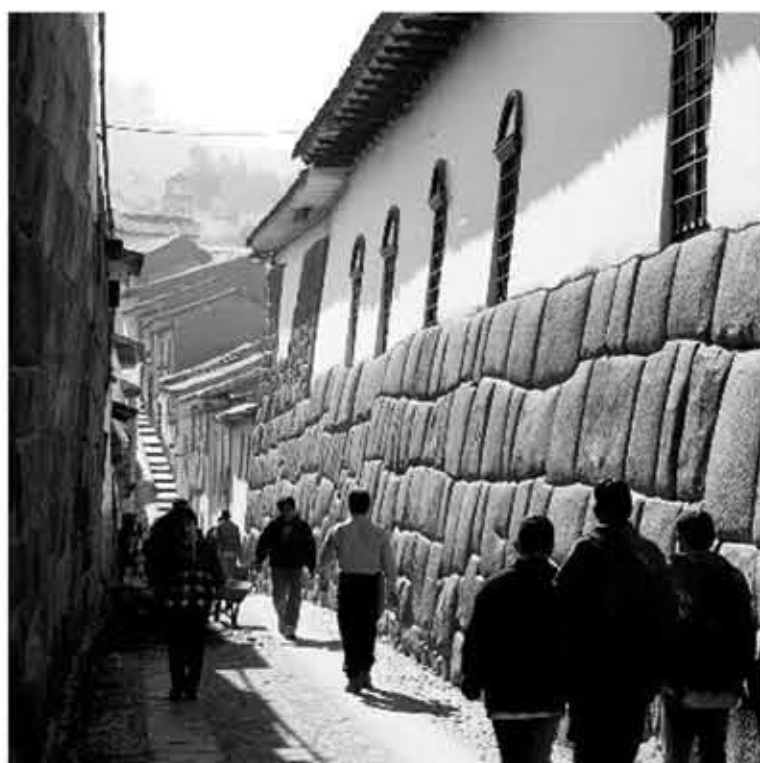
les murs incas servent de fondation aux constructions espagnoles Cuzco au Pérou
