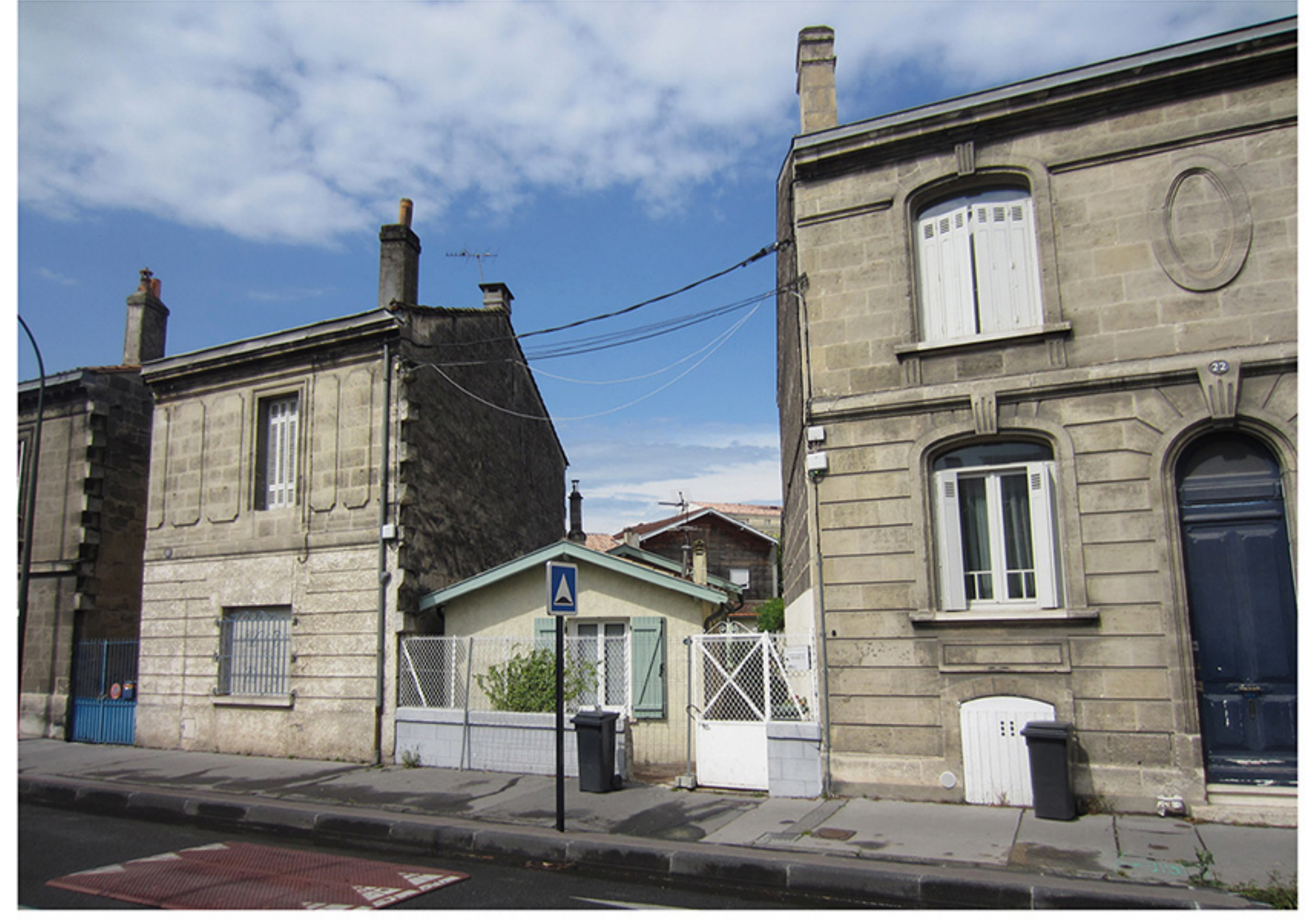
VUE DE L'EXISTANT
