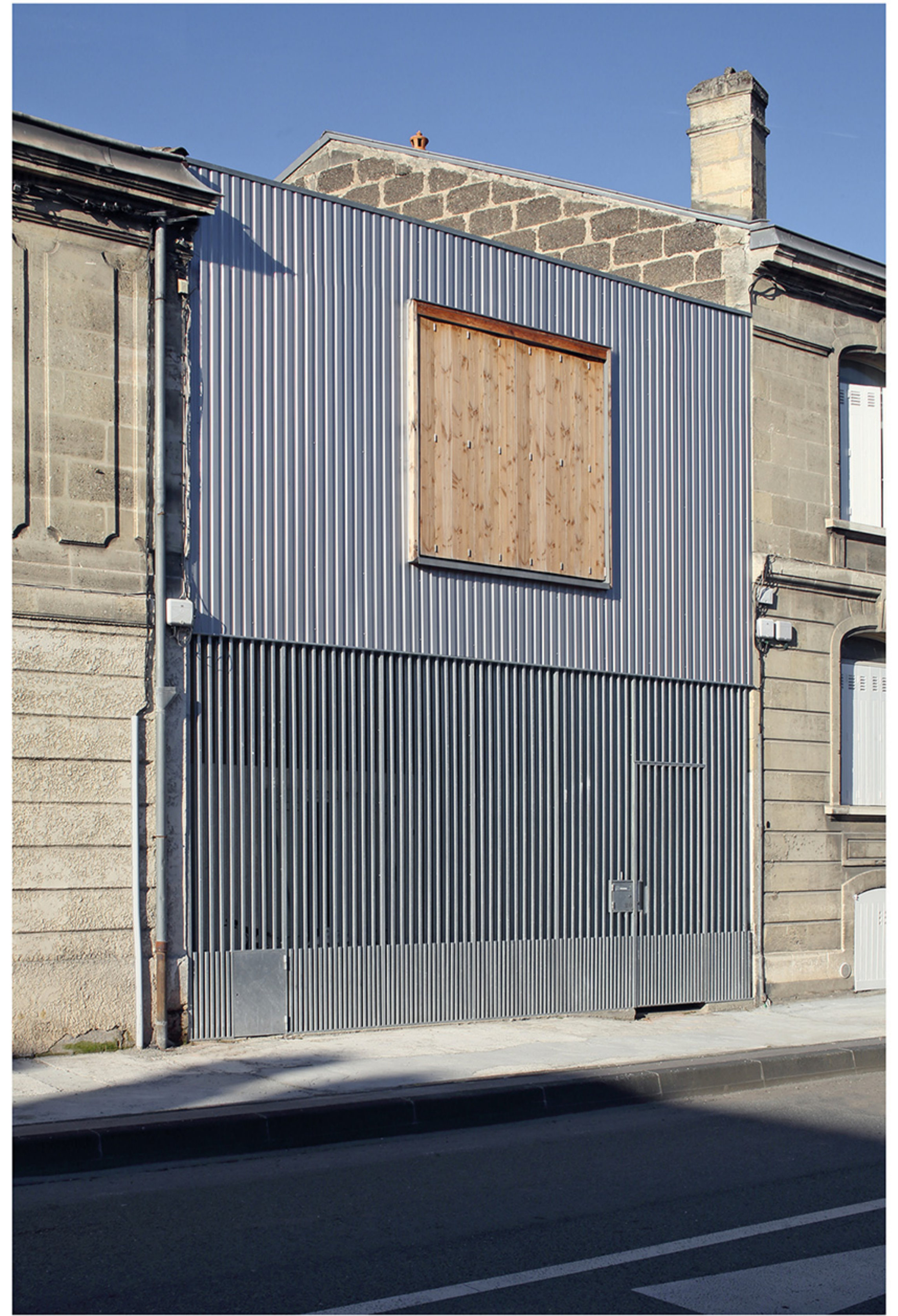
VUE DE LA FAÇADE SUR RUE APRES TRAVAUX
