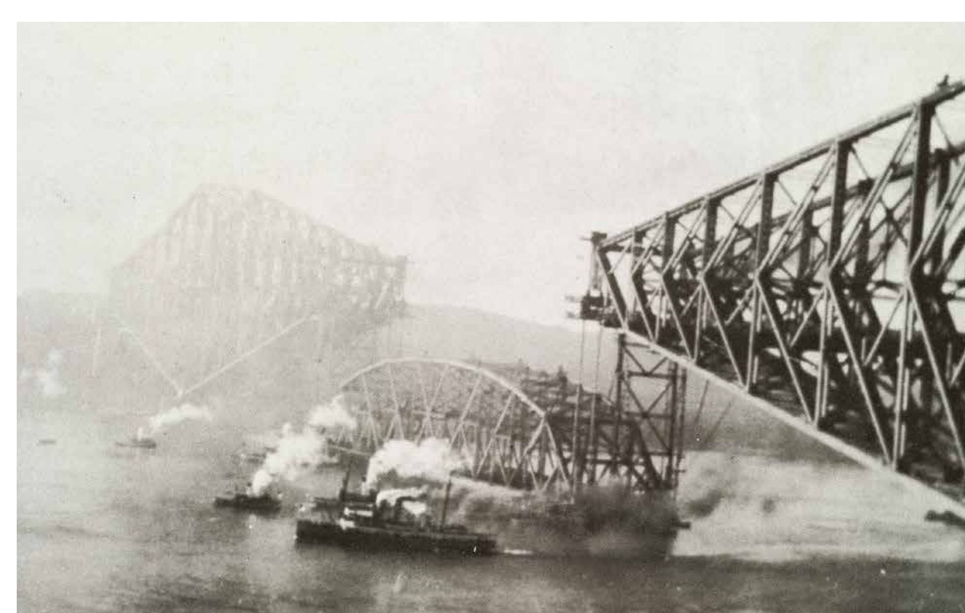
Construction du Port de Québec en 1916, installation de la travée centrale
