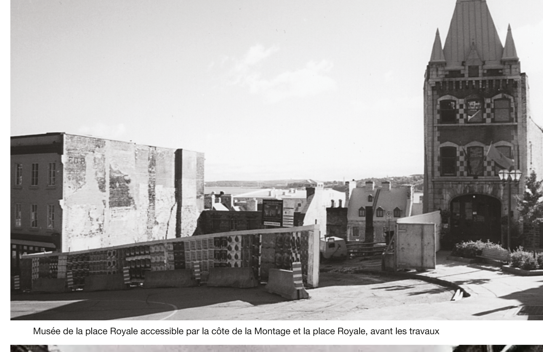
Musée de la place Royale accessible par la Côte de la Montagne et la place Royale, avant les travaux
