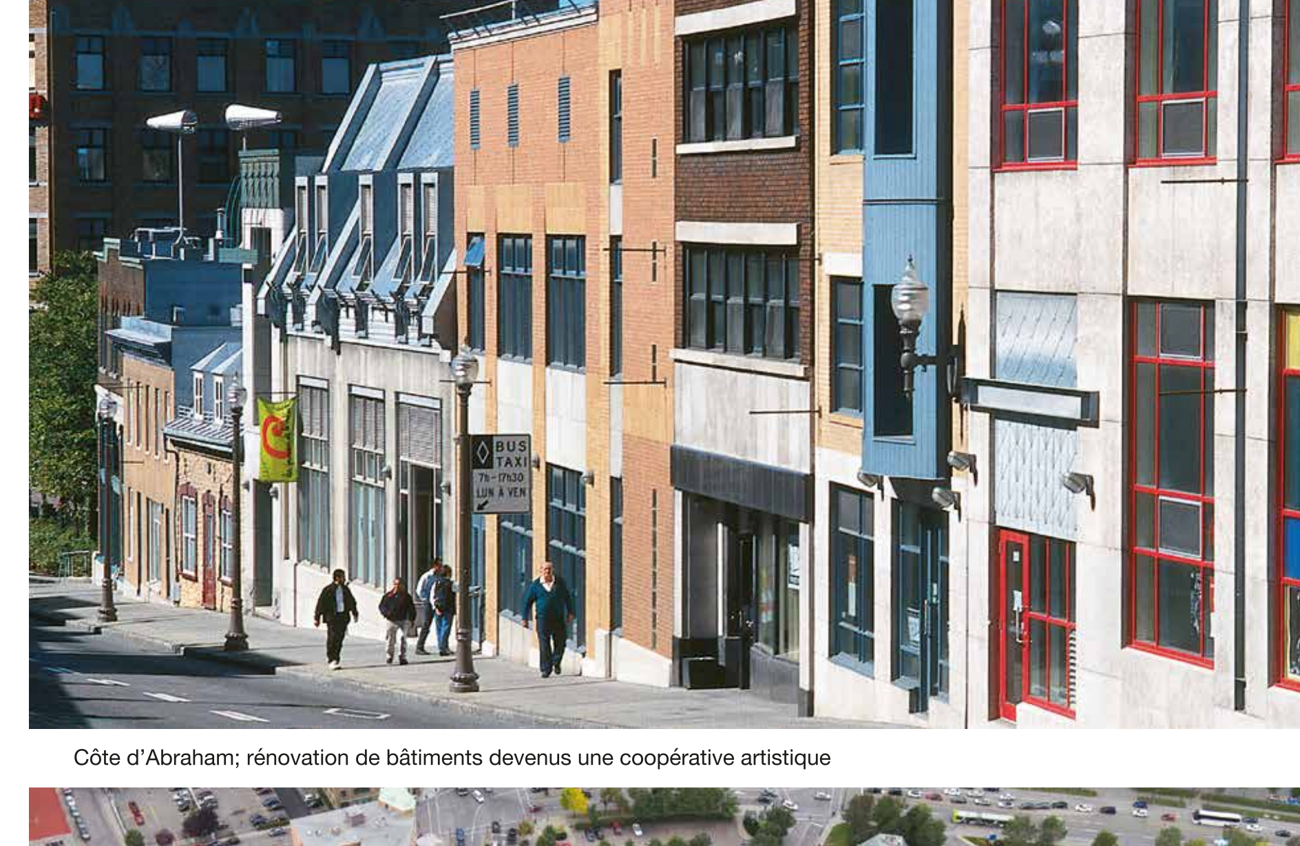
Côte d'Abraham; rénovation de bâtiments devenue une coopérative artistique
